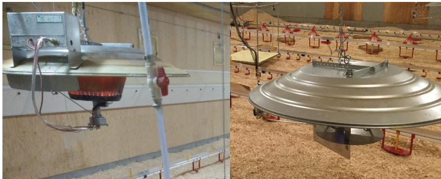
Figure 6. Photographie d'un chauffage au propane à gauche et d'un chauffage à tube radiant à droite (Images prises par Violette Caron Simard)
