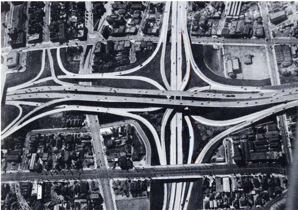
ILL. 5 – Photo aérienne d'un échangeur à Los Angeles, California
