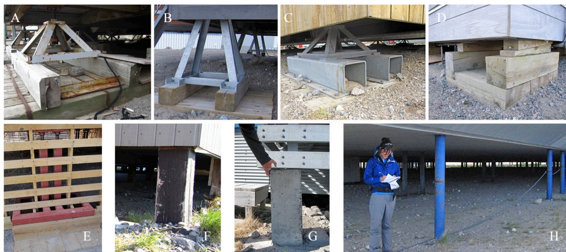
Figure 10. Types d'appuis inventoriés à Puvirnituk : A) et B) vérins à vis réglables sur piliers de bois traité ou C) sur piliers de métal; D) piliers de bois traité empilés avec cales ajustables; E) appui de métal à vis réglable; F) pilier de bois traité, ancrés dans une base en béton ; G) bloc de béton; H) pilotis métalliques, ancrés jusqu'au roc ou dans le pergélisol.
