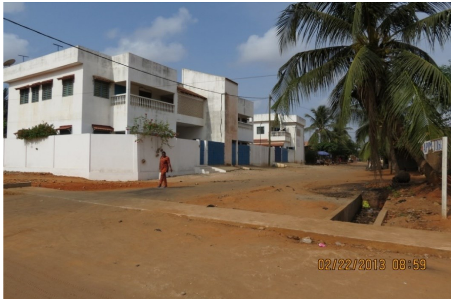
Photo N° 22 : Un ensemble d'immeuble d'appartements locatifs de la classe moyenne à Agbalépédogan, Lomé. Cliché Fiawumor, 2013.
