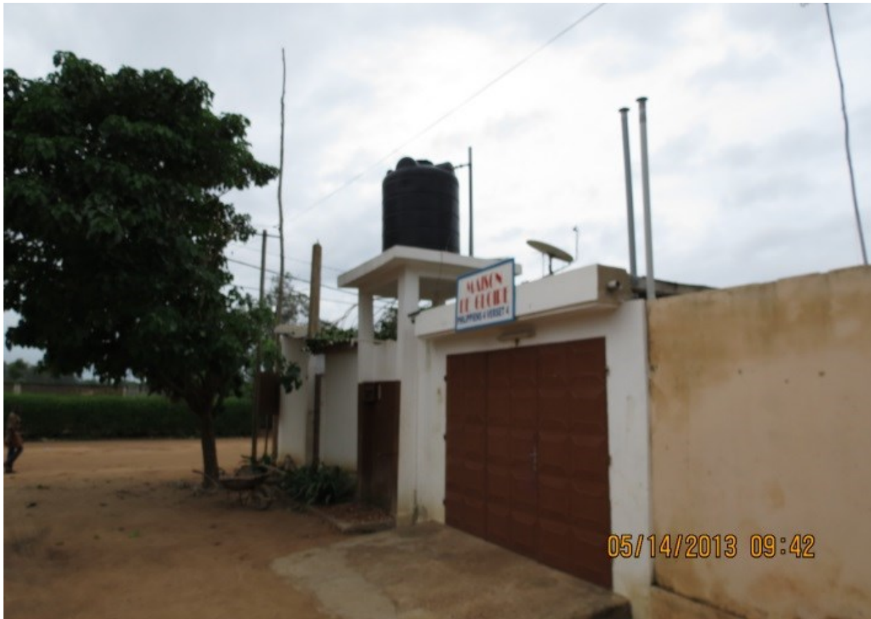
Photo N°2 : Poly tank (réservoir) dont l'utilisation se généralise à Lomé pour stocker l'eau de forage à l'aide d'une motopompe, cliché Fiawumor, 2013.
