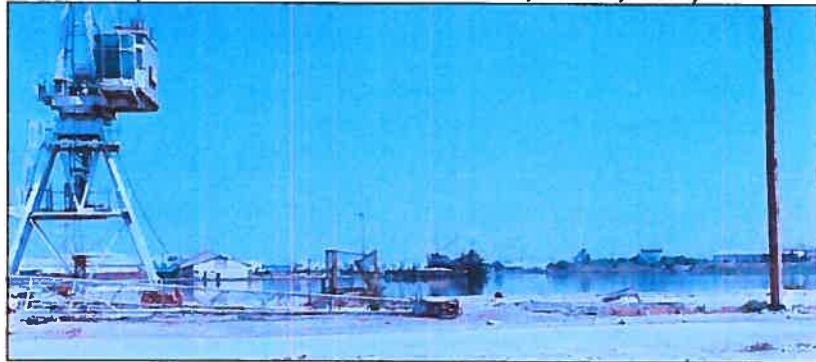
FIGURE 29 : État de dégradation de l'ancien port de Tunis (Source : Photo Sofiène AYADI, Juillet, 2006)
