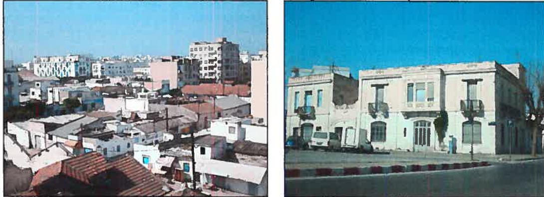
FIGURE 52 et FIGURE 53 : le manque d'entretien a causé la dégradation du quartier (Source : photos Sofiene Ayadi, Avril 2007)
