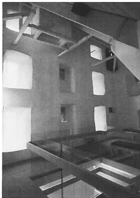
Figure 4 (À gauche) Vue de la jonction de l'aile sud et ouest. L'aile de gauche (sud) est une reconstitution historique alors que celle de droite (ouest) est « stylisé », mais non pas reconstitué. Il faut observer les détails des meneaux des lucarnes.
