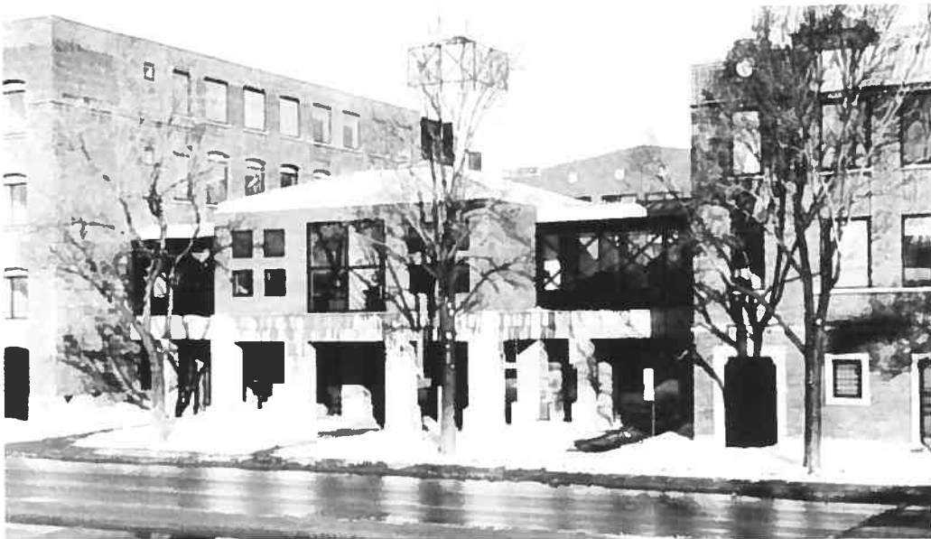
Figure 45 Vue du pavillon refermant la cour, entre les deux bâtiments préservés, depuis le boulevard Pie-IX.
