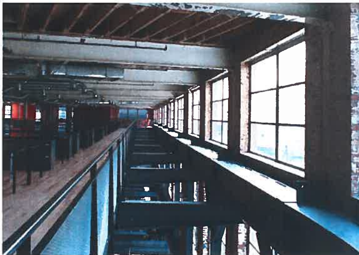
Figure 98 Vue du hall nord, partitionné par la construction d'une mezzanine.
