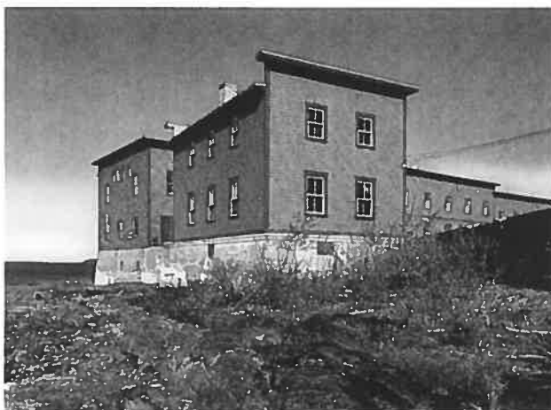
Figure 21 Vue du bâtiment de désinfection.
