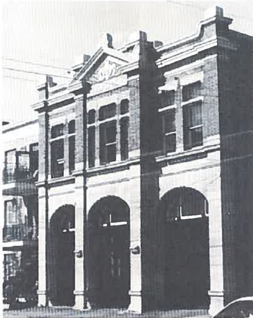
Figure 131 (À gauche) Vue ancienne de la caserne.
