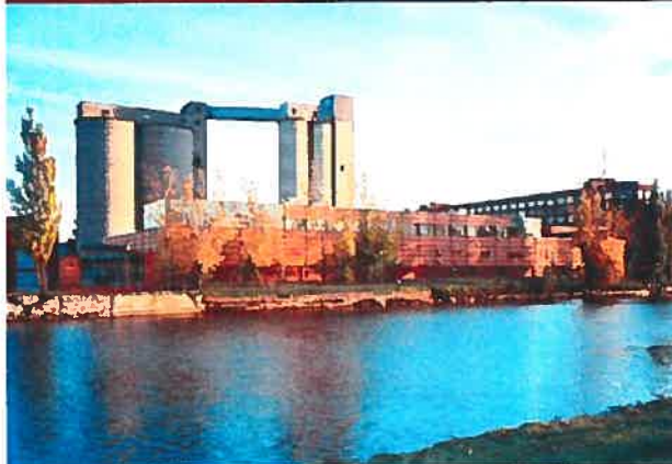
Figure 129 (À gauche) Vue de l'agrandissement, vers l'ouest.
