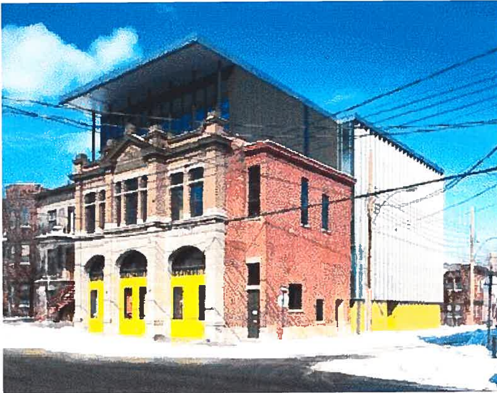
Figure 134 Vue du bâtiment, état actuel.
