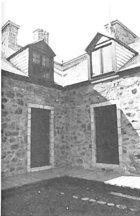
Figure 4 (À gauche) Vue de la jonction de l'aile sud et ouest. L'aile de gauche (sud) est une reconstitution historique alors que celle de droite (ouest) est « stylisé », mais non pas reconstitué. Il faut observer les détails des meneaux des lucarnes.
