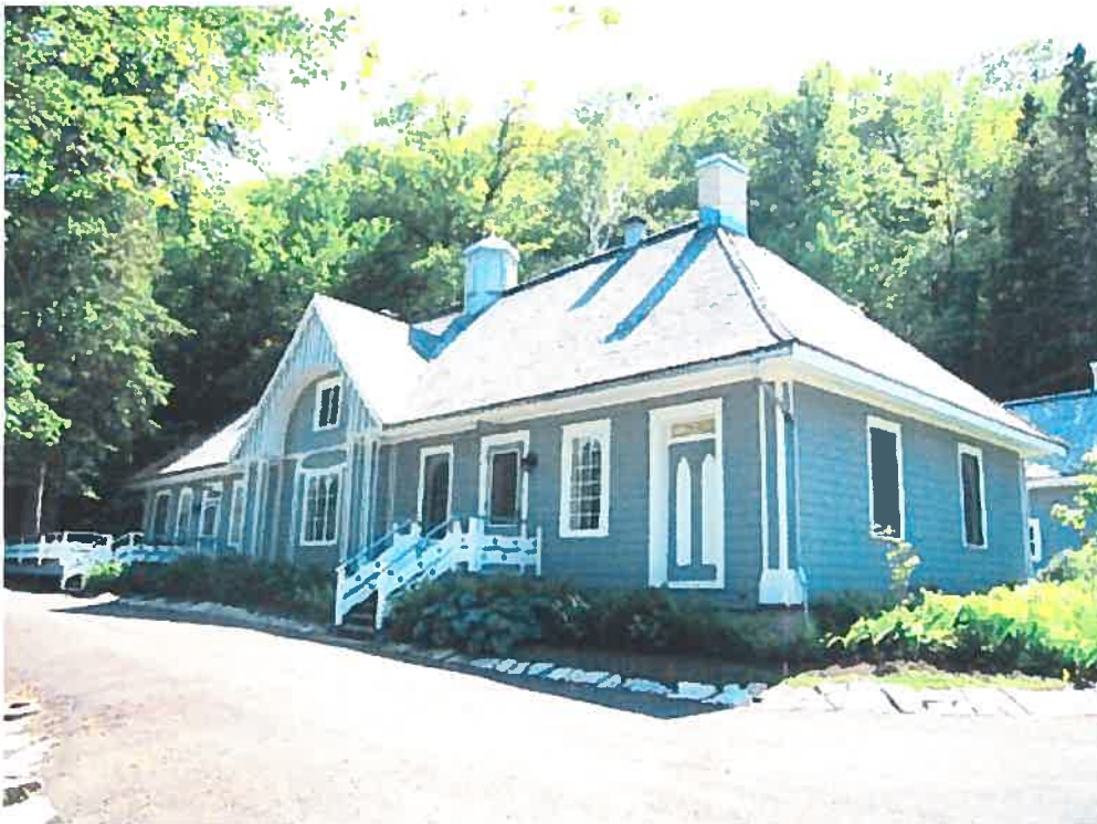
Figure 32 Vue de la maison des servantes aujourd'hui pavillon d'accueil
