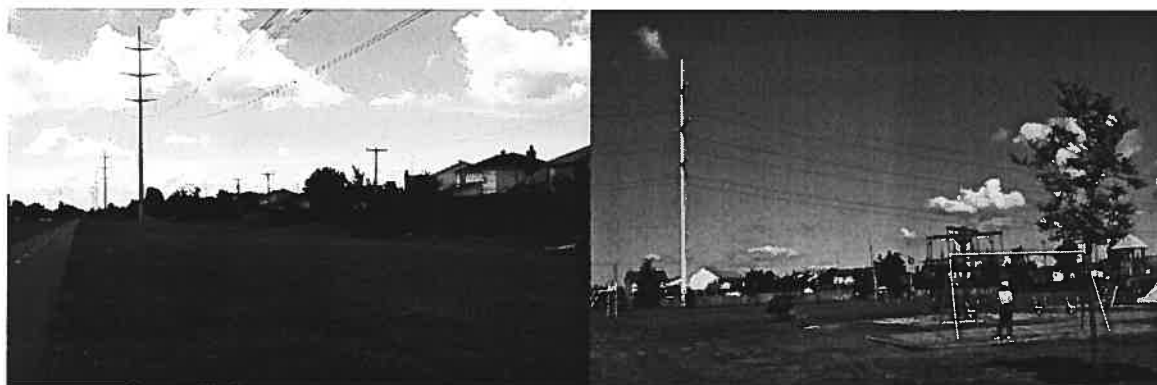
Figure 14_ Emprise de la ligne à 315 kV, Parc Trahan, Brossard. Photos : Chaire en paysage et environnement, 2001.
