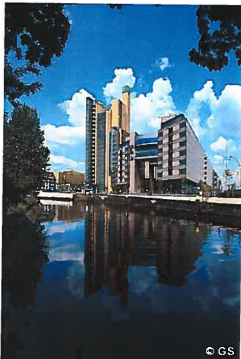
Figure 15 : Secteur Debis, Renzo Piano, 2005 Appartements, Arata Isozaki
