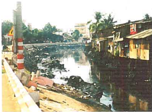
Le canal rempli de boue
