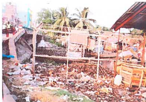
Déchets accumulés au pied du pont Bà Lài
