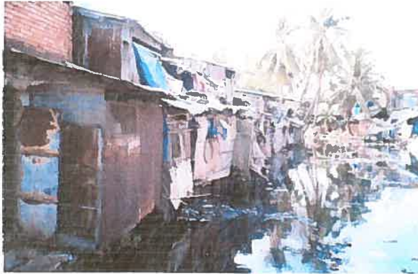
Maisons sur pilotis dans le quartier 11
