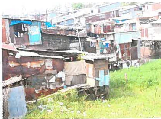
Une latrine publique dans un quartier sur pilotis
