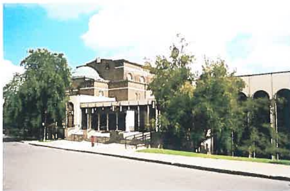
Figure 4.2 Synagogue de la Congrégation Shaar Hashomayim, chemin de la Côte-Saint-Antoine, angle avenue Kensington, à Westmount; son ancienne partie, à gauche, est jumelée avec une nouvelle, ce qui la rend très vaste.
