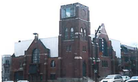
Figure 8.3 L'ancienne église catholique Saint-Robert-Bellarmin, dont la paroisse fut supprimée en 1994 et ses registres transférés à la paroisse voisine de l'Immaculée-Conception, a été transformée en un espace chorégraphique (école de danse) de la Fondation Jean-Pierre-Perreault. Dans sa transformation, le bâtiment a conservé son clocher et ses murs extérieurs, tandis que tout le toit a été modifié afin de répondre aux besoins des nouveaux acquéreurs : il se situe sur la rue Sherbrooke Est au coin de l'avenue de Lorimier dans l'arrondissement Ville-Marie.
