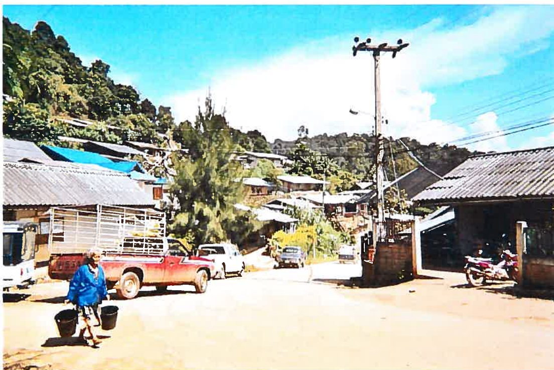
Photographie 16 : Réseau électrique à Nong Hoi Khao
