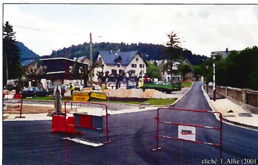
Photo 2: L'amélioration de la route à Saint-Nizier-du-Moucherotte
