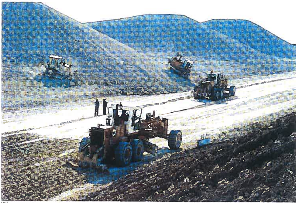
Figure 16. Travail du sol au bulldozer. Aire d'autoroute de Villeroy (1997), Yonne, France. Paysagiste : Jacques Simon. Architecte : Denis Sloan. Source : Hucliez (1998 : 48).
