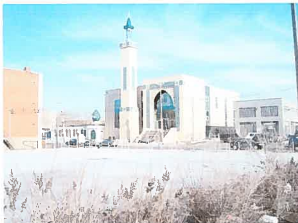
1 Architecture symbolique Formes et matériaux contemporains
