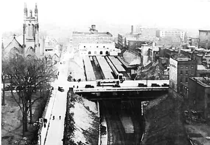
Figure 5 Tranchée et gare temporaire du CN, 1930. Collection de photographies du CN
