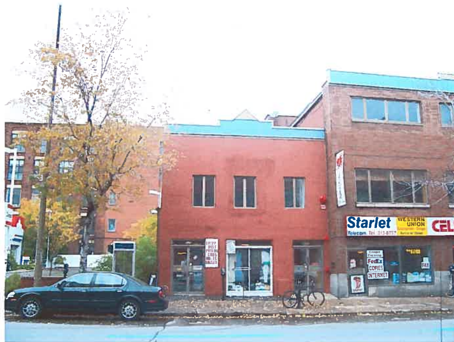
Figure 77 : Photo de la façade en 2005.
