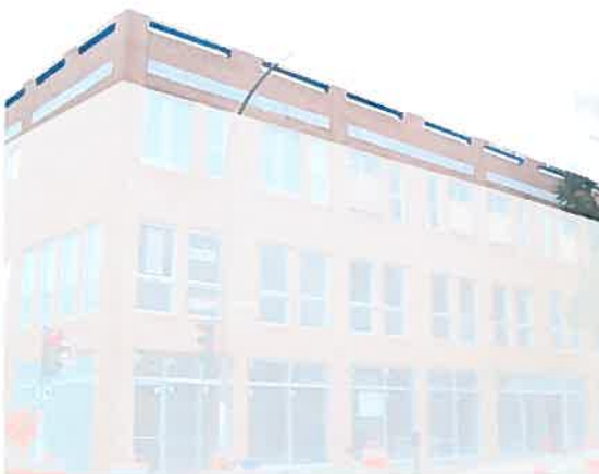
Figure 62 : Détail du couronnement.
