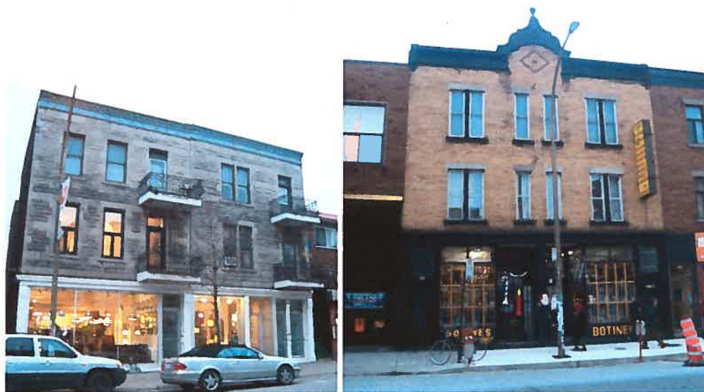
Figure 23 : Bâtiments datant du début du siècle avec différents matériaux, couleurs et types de couronnements.
