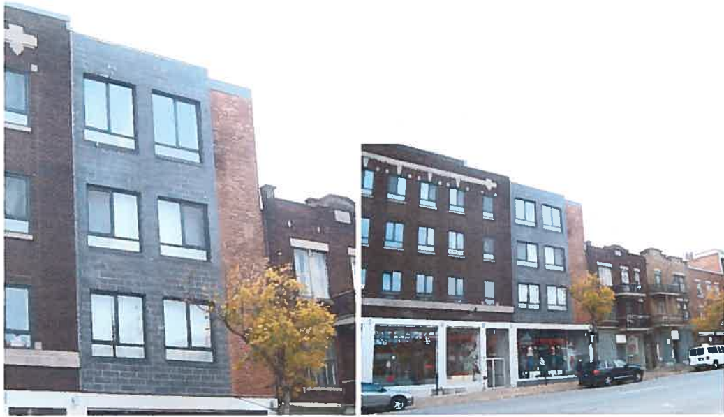
Figure 70 : Le traitement de la façade.
