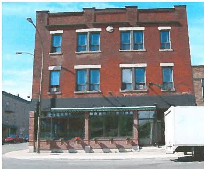
Figure 87 : Photo du bâtiment datant de 2004.
