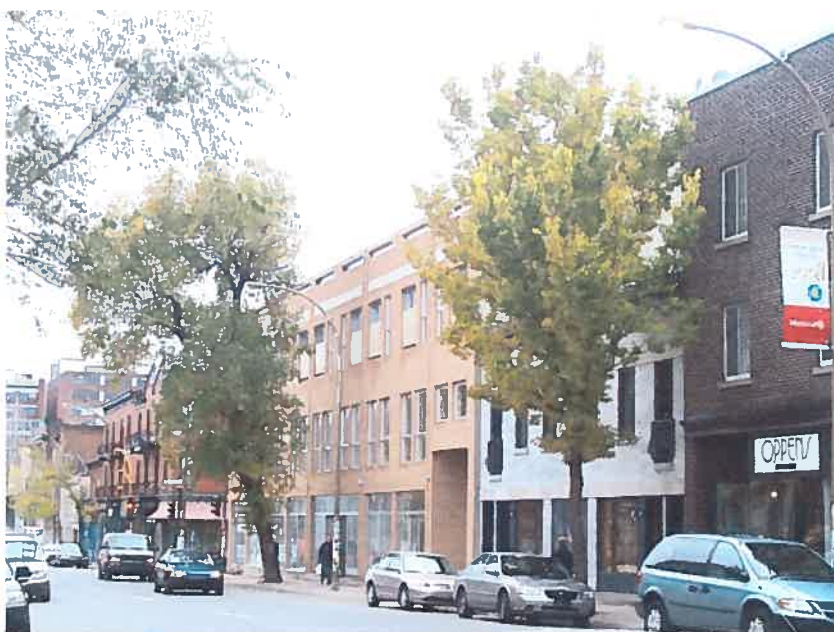
Figure 63 : Le bâtiment dans son contexte.
