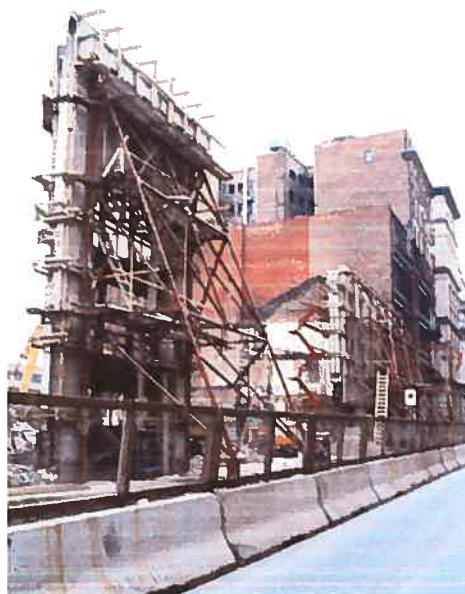
Figure 2 : Chantier du Centre de commerce international, Montréal.
