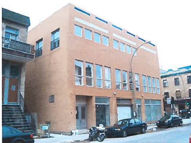
Figure 61 : Façade sur la rue Villeneuve.
