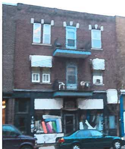
Figure 30 : Exemple de bâtiment à vocation mixte datant des années 1930.
