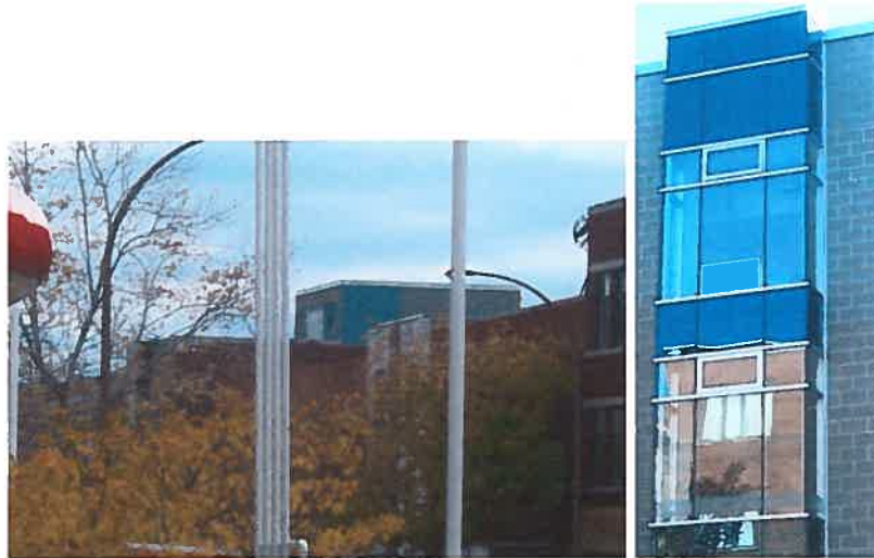
Figure 66 : L'étage en retrait et détail de la façade.
