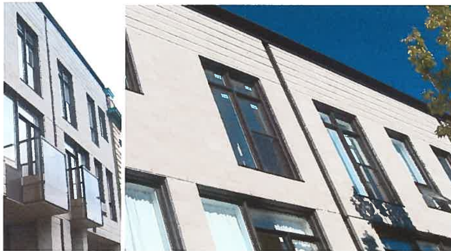
Figure 56 : Détails de la façade.
