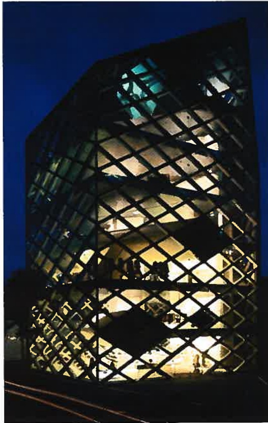
Figure 6 : Photographie nocturne du Prada à Tokyo conçu par Herzog & de Meuron en 2003.
