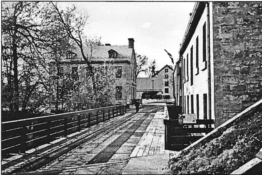
Figure 12. Vue de l'entrée de l'île-des-Moulins après la restauration des lieux, au milieu des années 1970. (source : Brigitte Gervais, 2002)
