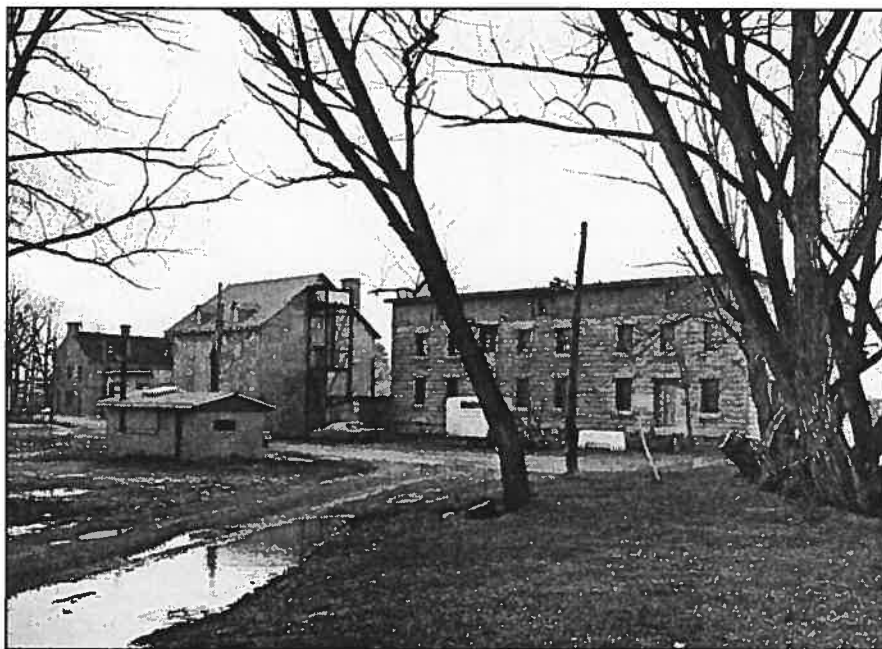
Figure 11. Une section de l'Ile-des-Moulins avant que celle-ci soit classée « site d'intérêt historique national » par le ministère des Affaires culturelles du Québec en 1973. (source : Ile des Moulins)
