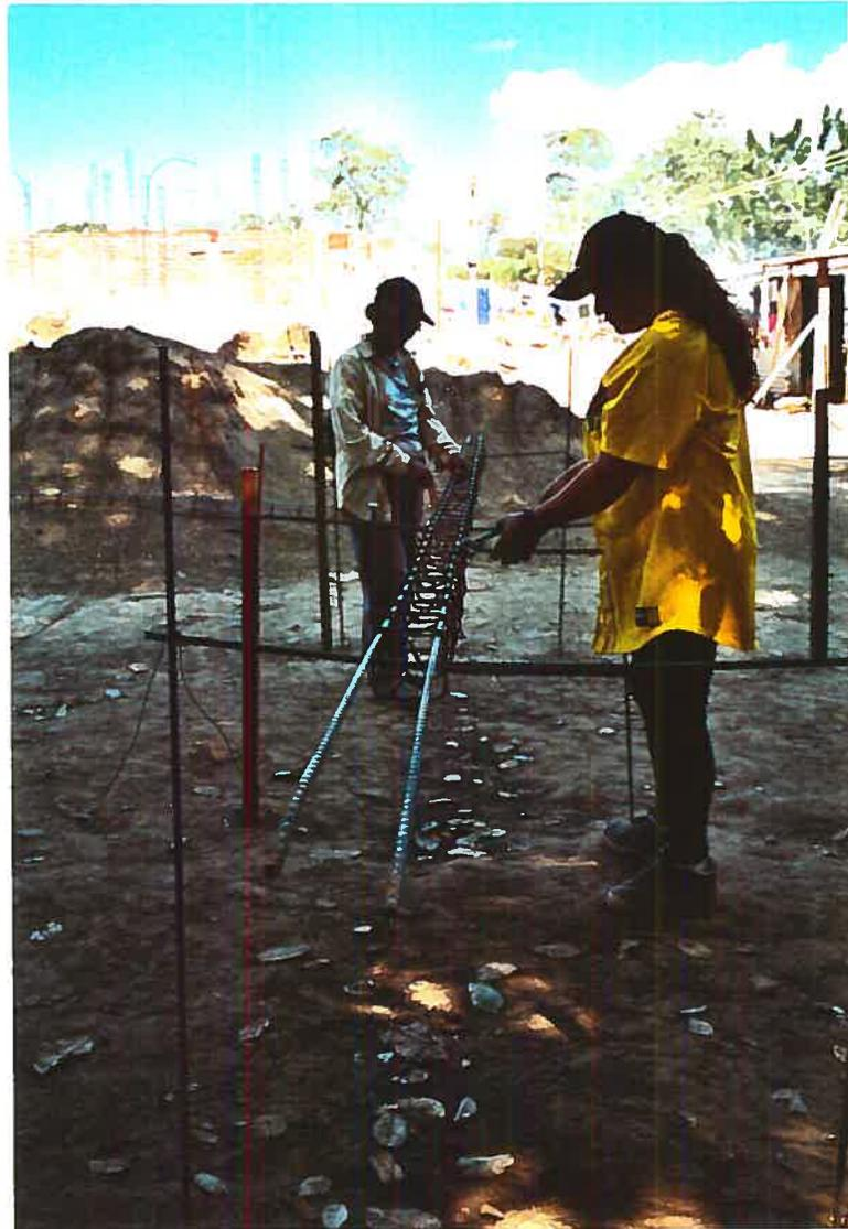
*Armadoras* fabriquant une colonne de fer.
