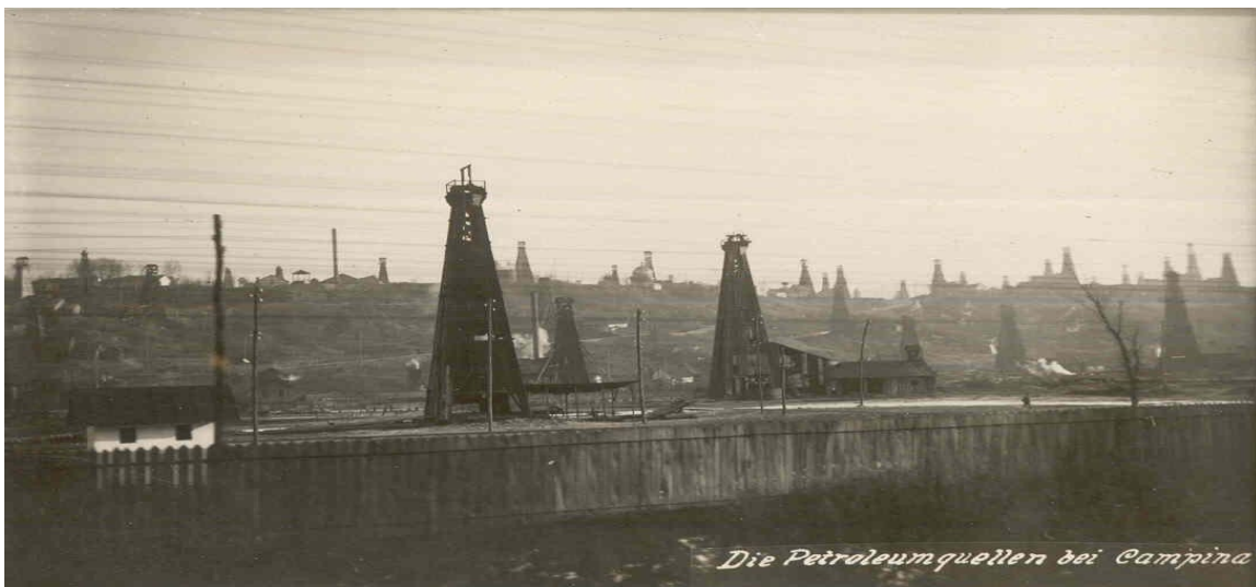
Derricks de forage à Campina. Source : Christian Rouxel, op. cit.
