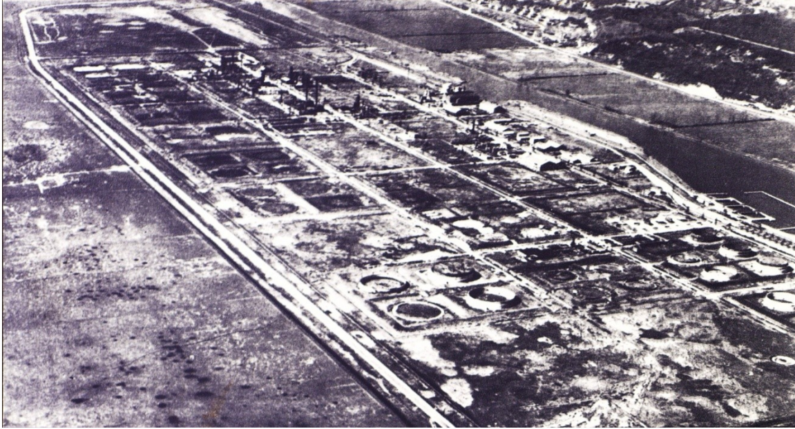
Raffineries de la CFR pendant et après les bombardements. Source : Archives Total.
