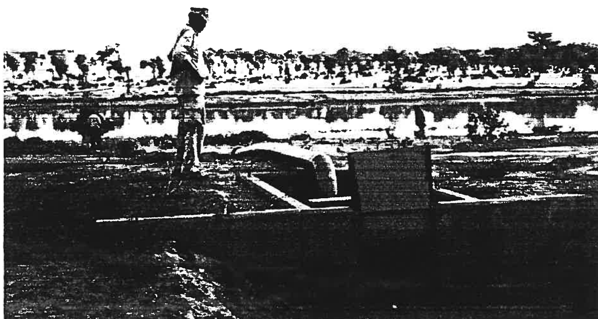
Photo3 : Système de van – tuyau flexible –bassin de rétention
