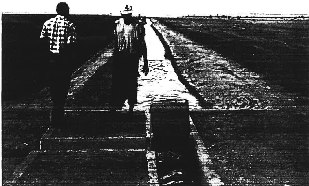
Photo 6 : Système – Canal-Partiteur – vanne
