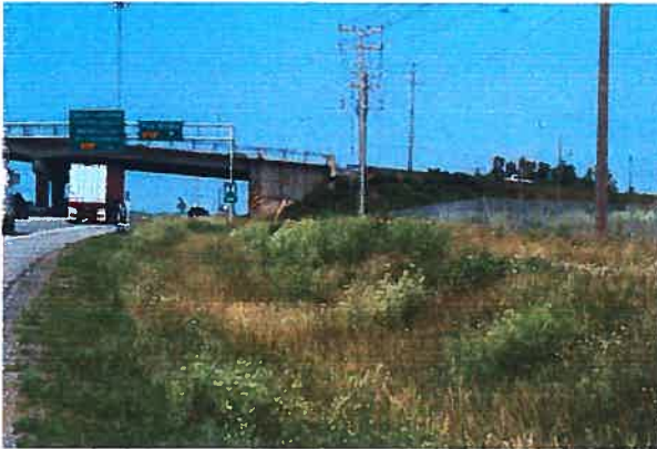
Figure 2a. Démarcation nette entre l'emprise latérale et le contexte à cause de la présence de la clôture. Prise de vue effectuée sur l'autoroute 15 nord à la hauteur de Saint-Jérôme le 27 juin 2001. Photo : J. Froment.
