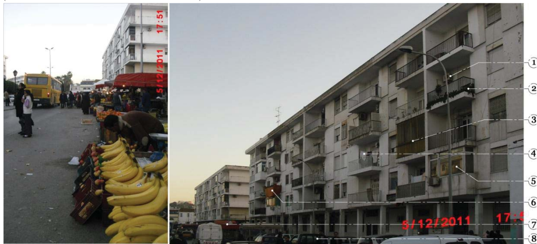
Fig. C.1.16 : Nouveaux modes d'occupation de la voie et de la façade publiques
