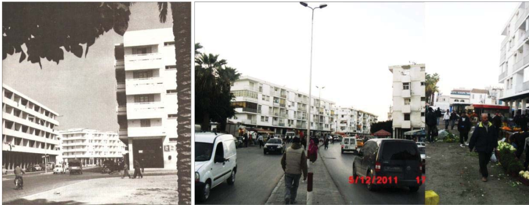
Fig. C.1.15 : Etat actuel de la percée Sidi El-Béehir
