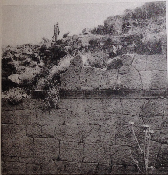
2 - Appareil polygonal à joints courbes (Larissa sur l'Hermos)
