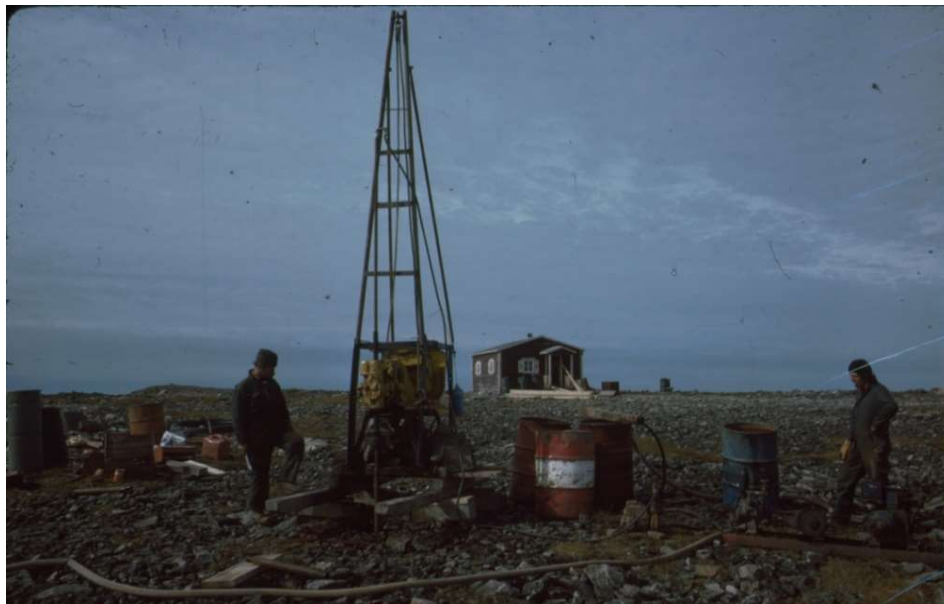
Figure 20: Forage au sommet du mont Jacques-Cartier en 1977 (Photo : James Gray).
