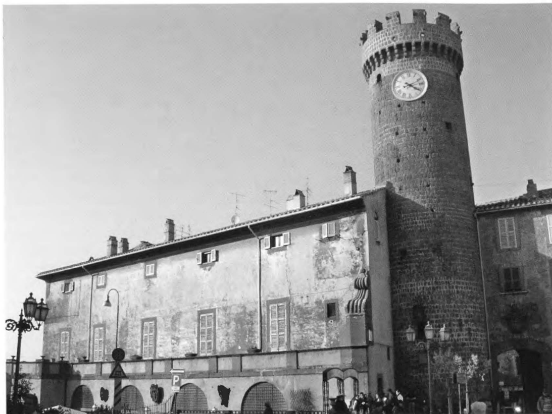
1. Bagnai, Palazzo Vescovile, facciata sud.
