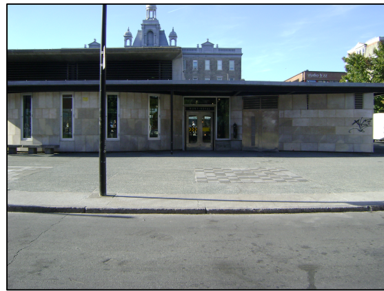
Figure 9: Surface pavée à l'arrière de l'édicule
