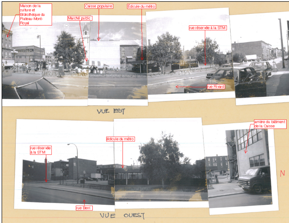
Figure 5: Site du métro Mont-Royal, 1985, vue Est et vue Ouest
