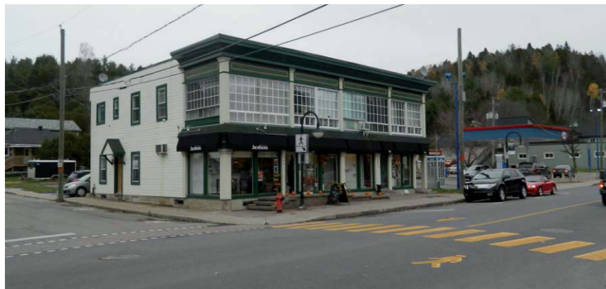
Figure 12 - Traverse piétonne dans Mont-Tremblant (secteur Saint-Jovite)
