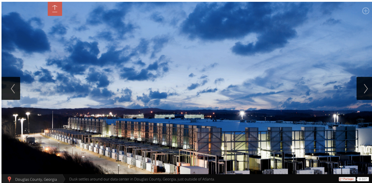
Figure 12.2 : Centre d'exploitation de données de Douglas County en Georgie, capture d'écran partielle du site de présentation des Data Centers de Google, accessible au http://www.google.com/about/datacenters/gallery/#/places/8 , captée par Christelle Proulx le 8 janvier 2014.
