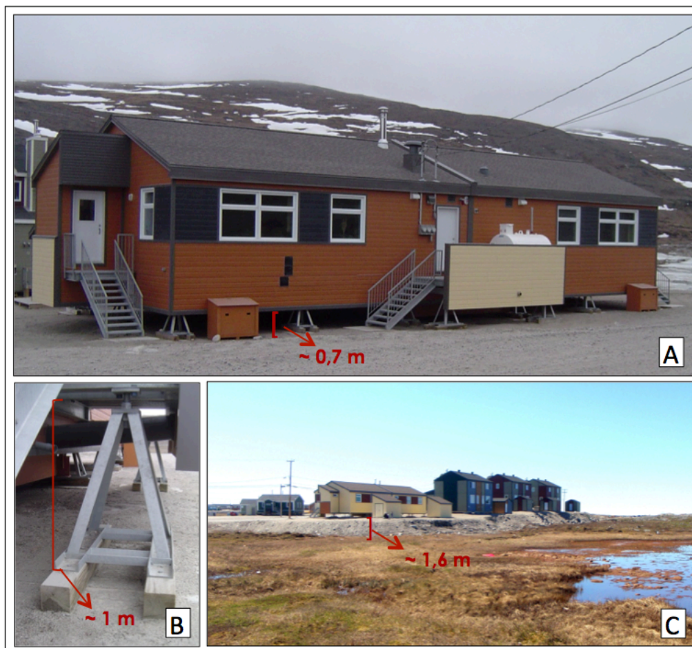
Figure 4. A) Bâtiment unifamilial nordique surélevé; B) Vérin à vis ajustable reposant sur des blocs de bois et supportant la structure en acier du bâtiment; C) Bâtiment reposant sur un radier de quelques mètres d'épaisseur.
