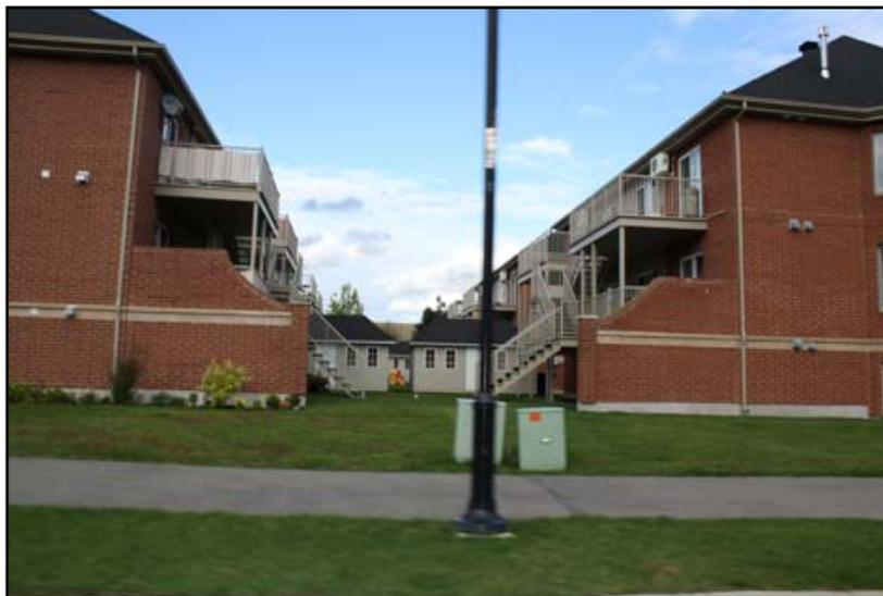
Un exemple de gouttière (ligne beige) d'un toit d'une rangée de duplex dirigée vers une surface de gazon. Photo prise par l'auteur, 2010.
