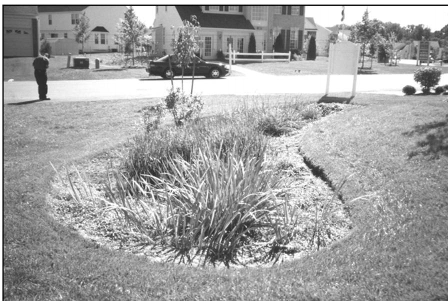
Figure 3.2 : Exemple d'une zone de biorétention insérée dans la pelouse dans un quartier résidentiel. On peut percevoir une petite dépression (8 cm) permettant de recueillir et d'accumuler le ruissellement (Prince George's County, 2007, p. 21).
