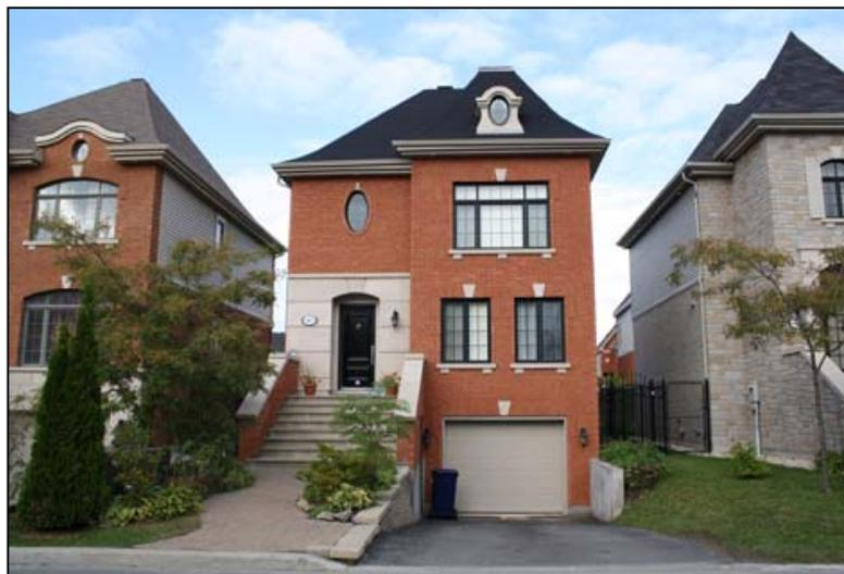
Exemple de pavage connecté situé en façade d'une maison *Confort*. Du côté gauche, le pavé uni renvoie les eaux vers la rue et, du côté droit, le stationnement en pente vers la maison dirige les eaux pluviales vers un drain connecté avec le réseau pluvial souterrain. Photo prise par l'auteure, 2010.
