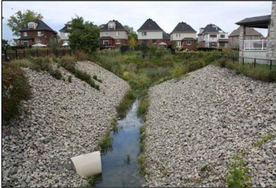
Photo présentant le travail d'enrochement (à l'avant) de la rive du ruisseau où sont dirigées les eaux de ruissellement. On peut voir des travaux de génie végétal au fond de la photo. Photo prise par l'auteur, 2010.
