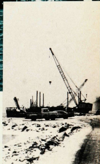
Pour les ingénieurs, une technique n'attend pas l'autre. Le pont Champlain fut le premier de cette taille en béton précontraint.
