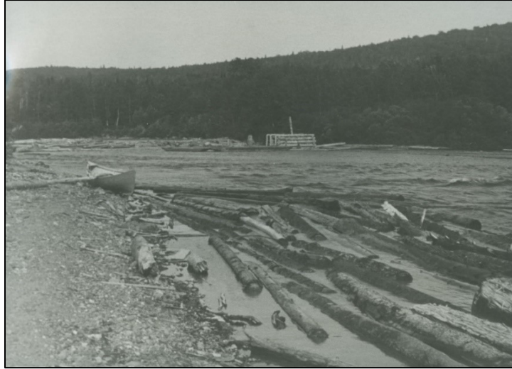
Figure-A.19.– Structure d'écluse sur la rivière Touladi, 1915 (Source : Musée McCord, Montréal, V5486)
