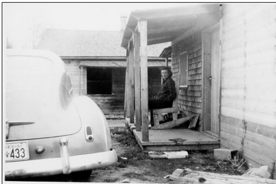
Figure-A.7.–Photo du bureau du contremaître au camp de la Terre-à-Fer en 1951. On peut y voir le mode de revêtement des bâtiments en bardeaux de cèdre et en planches (Source : Collection Albert Lebel)
