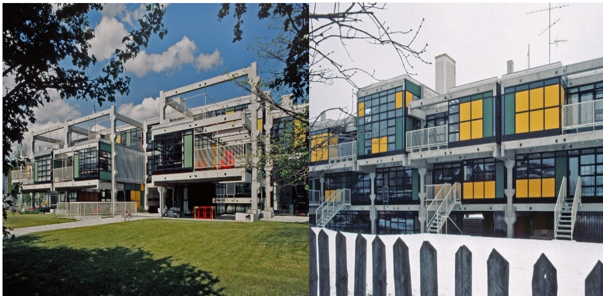
Figure 2.2. Wohnanlage Genter Strasse exterior infill
