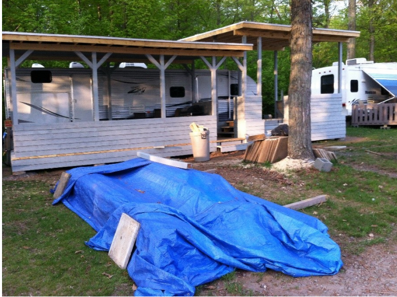
Figure 9. Un terrain en chantier en début de saison au camping des Palmiers . Mai 2016
