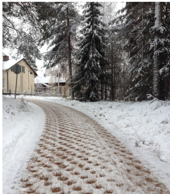
FIGURE 13 SENTIER PÉDESTRE ET CYCLABLE DE NEIGE TAPPÉE AVEC DES CREUX ET UNE COUCHE DE SABLE DANS LA VILLE DE ROVANIEMI
