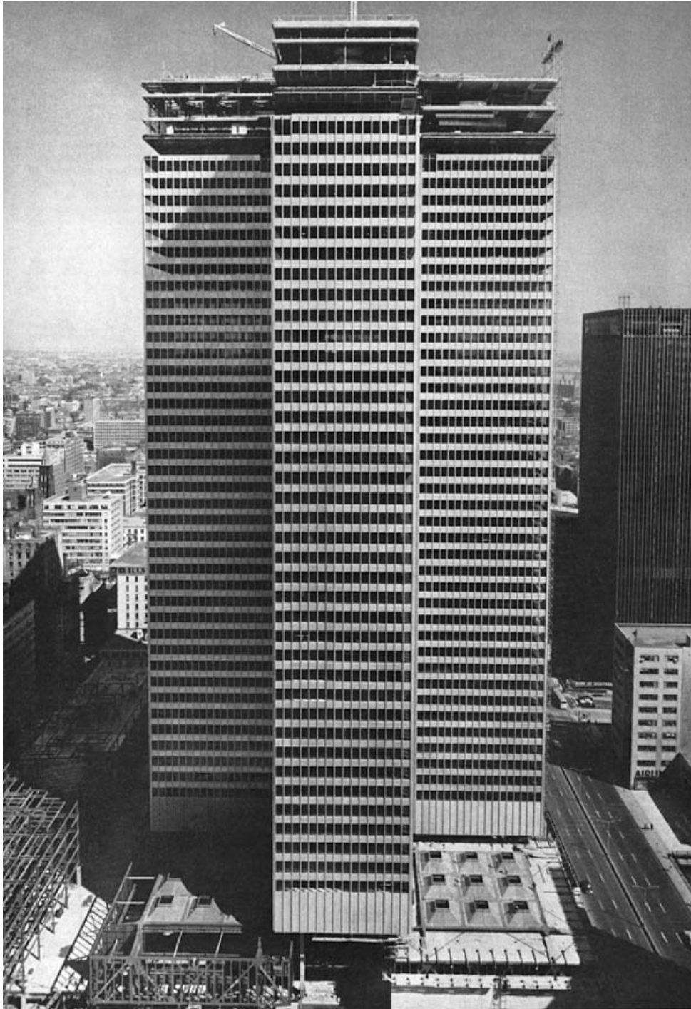
Photo tirée de la Revue Architecture, Bâtiment, Construction , n° 186, octobre 1961.
