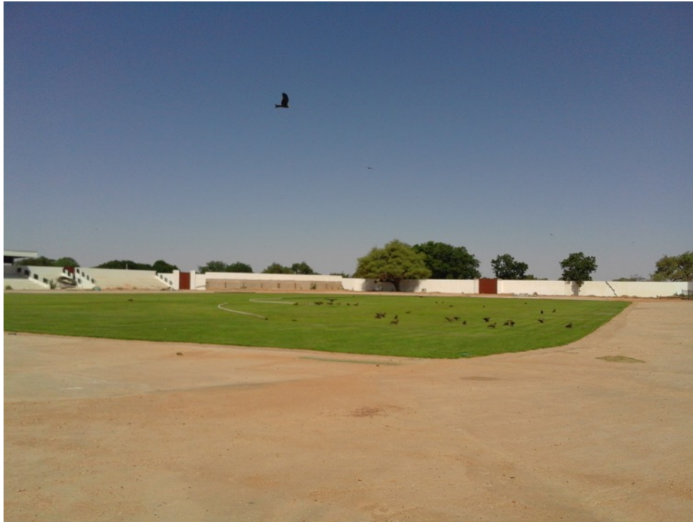
Figure 1. La « Cité Olympique » en construction, El Obeid
