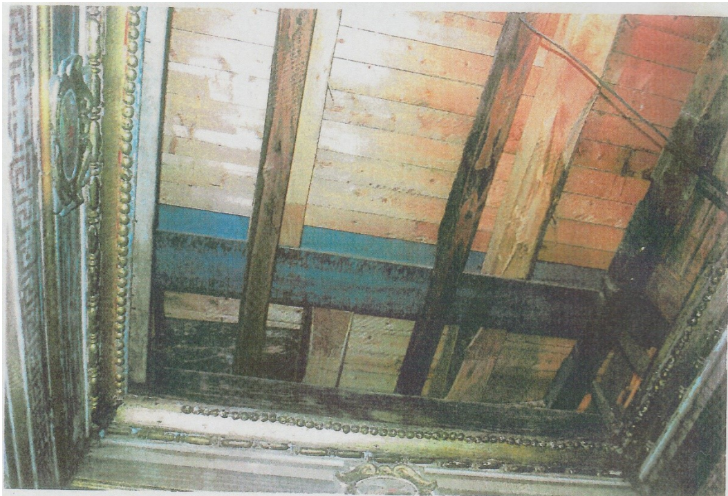
Figure 31. Structure portante du plafond après l'intervention de 2010, photographie, chambre des éléments, villa Médicis, Rome. Source : Laboratorio Scientifico del Museo d'Arte et Scienza di Gottfried Matthaes (2010).
