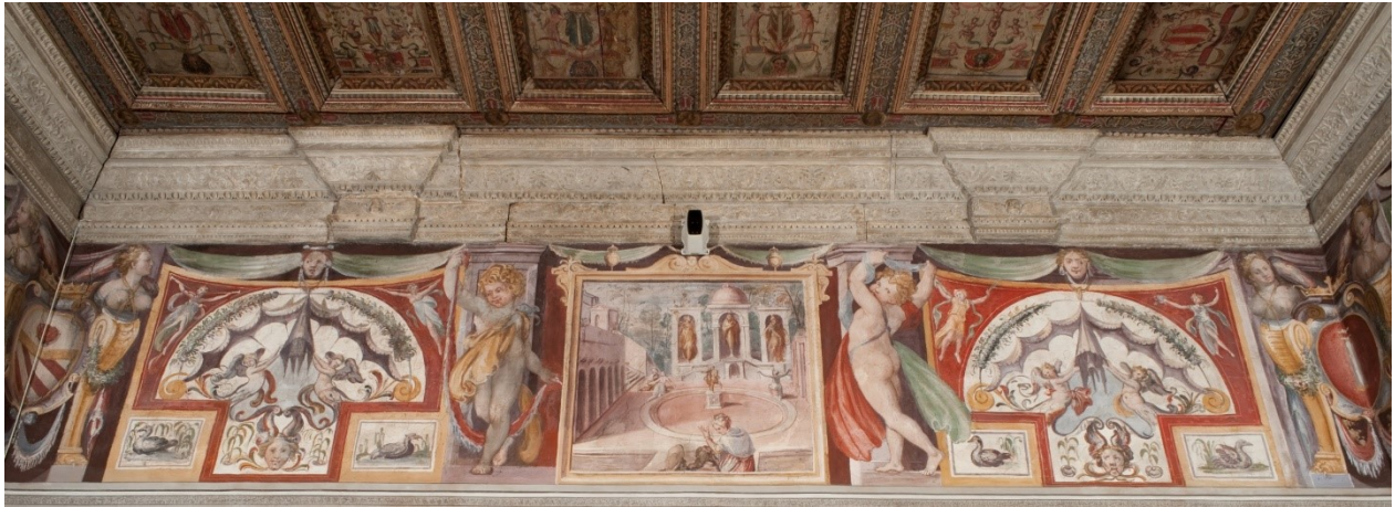
Figure 70. Matteo Neroni (?), frise, 1564-1568 (?), mur est, pièce centrale du piano nobile , palazzo del Vaso (Colonna), Santi Apostoli, Rome. © Humberto N. Serri (2012).
