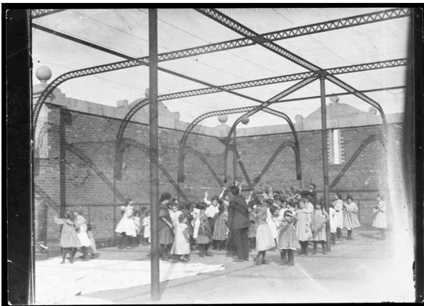
Figure 175 - La cour de récréation sur le toit de l'école # 20, vers 1895
