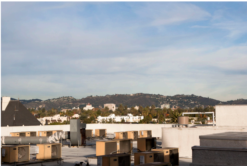
Figure 1 - Le toit dans une perspective purement fonctionnelle : unités d'air conditionnée et système de ventilation sur un toit à Los Angeles
