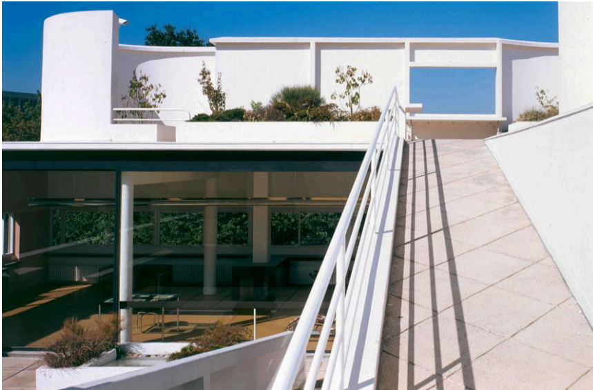
Figure 15 - La rampe menant au solarium de la villa Savoye
