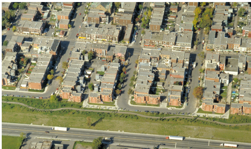
Figure 2 - Des toits qui recèlent un fort potentiel de développement : toits plats typiques de Montréal
