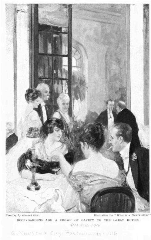
Figure 154 - Le roof garden d'un hôtel, 1916
