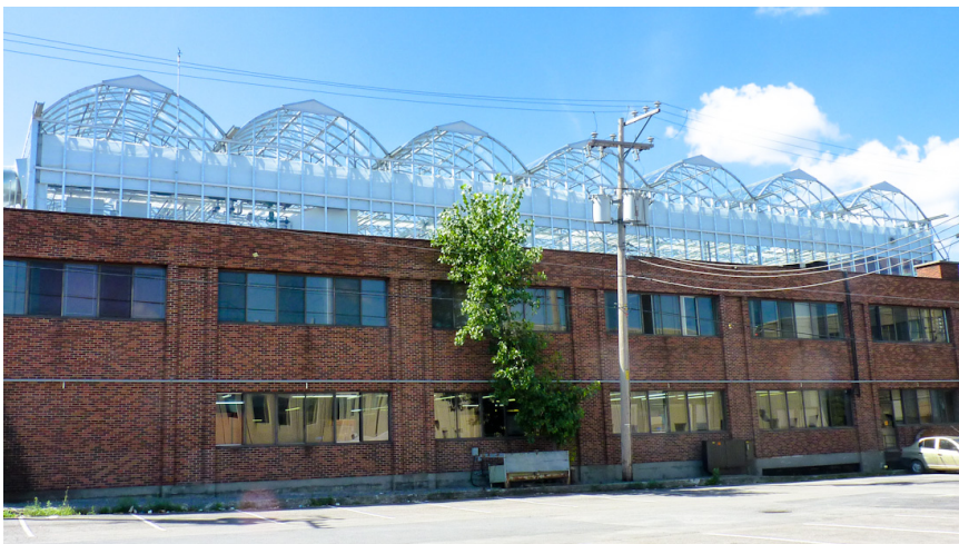
Figure 14 - La serre commerciale sur toit des Fermes Lufa à Montréal
