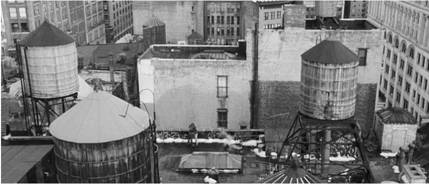
Figure 47 - Ensemble de plusieurs éléments fixes sur le toit dans Rent (2005)
