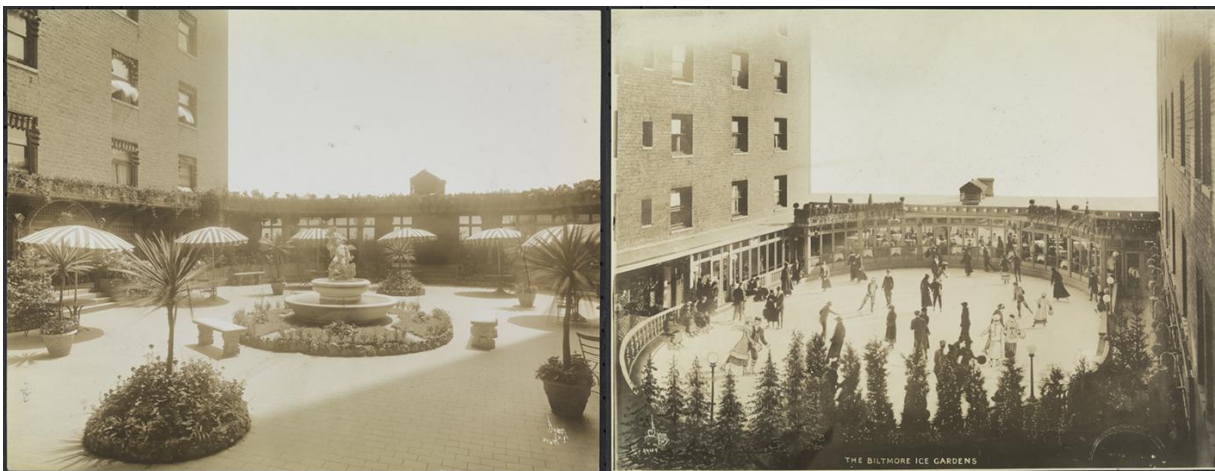
Figure 180 - Le roof garden du Hotel Biltmore, vers 1915
