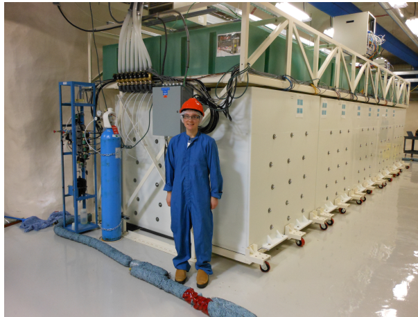
Figure 4.2 – Trente-deux détecteurs PICASSO dans les installations de SNOLAB, à Sudbury. La photographie a été prise lors d'une opération d'entretien visant à remplacer des cartes d'amplification défectueuses.
